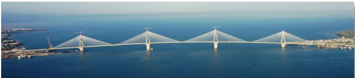
Die 2.883 Meter lange Brücke besteht aus der 2.252 Meter langen Hauptbrücke über dem Meer und der 392 Meter langen Rampenbrücke für die Zufahrt bei Río sowie der 239 Meter langen Rampenbrücke bei Andirrio. Die Hauptbrücke hat vier **Pylone** und Stützweiten von 286 Metern, drei Mal 560 Metern und 286 Metern; sie ist damit die zweitlängste **Schrägseilbrücke** der Welt.
